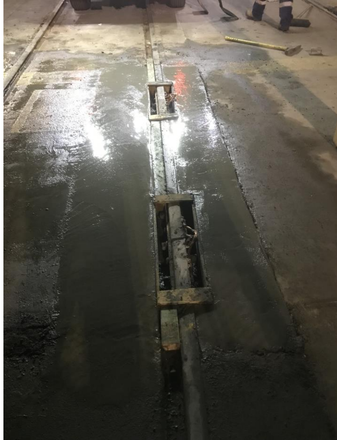
Concrete Slab at the end of the pour
